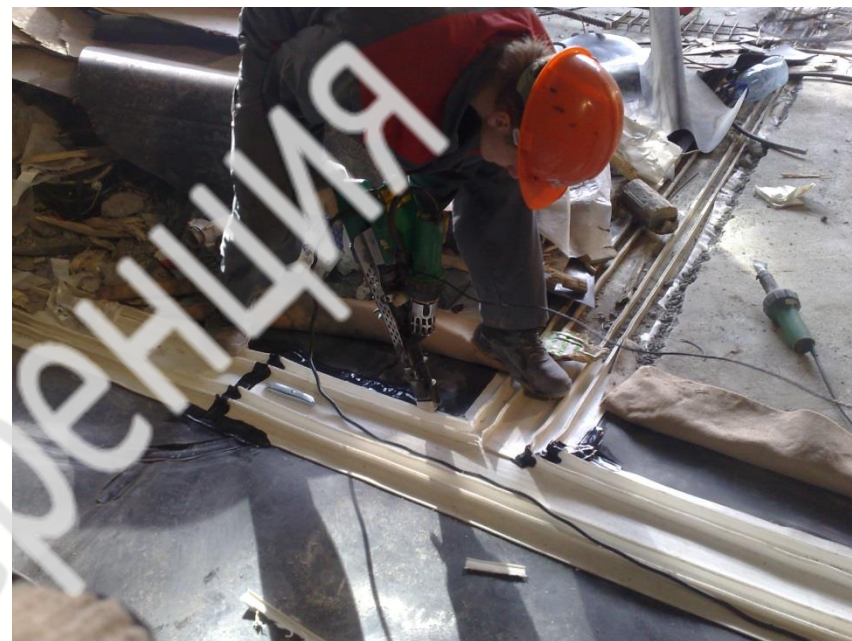
Сварка с полиэтиленовым профилем
