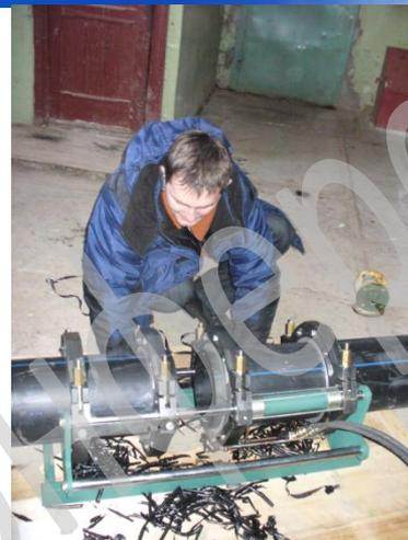
Ø225 мм  $e_n=20\text{мм}$
