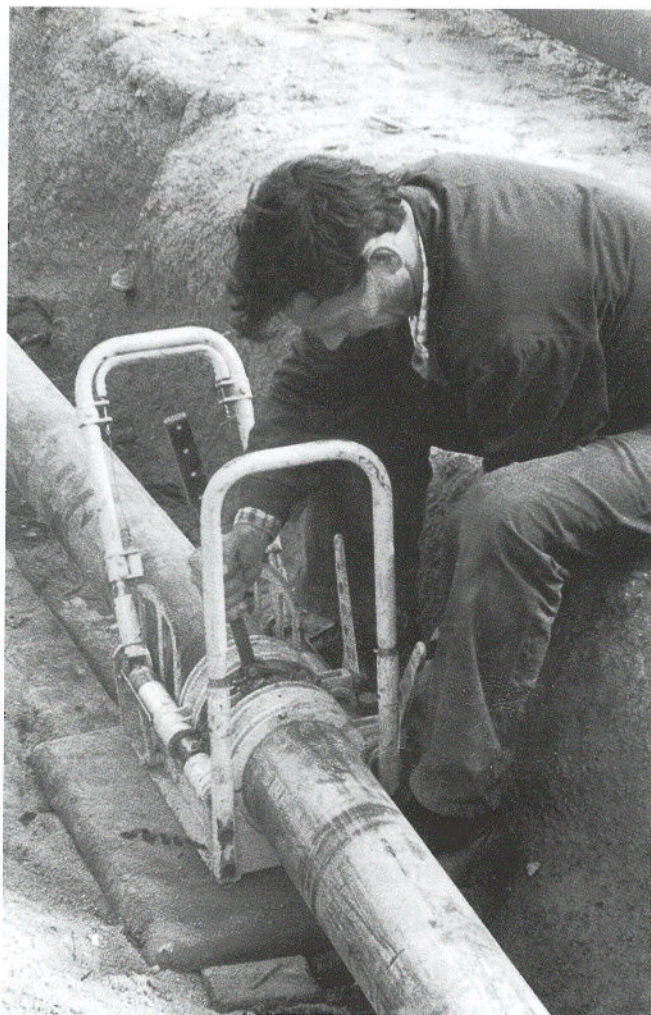
Переносная сварочная установка ВНИИСТ
