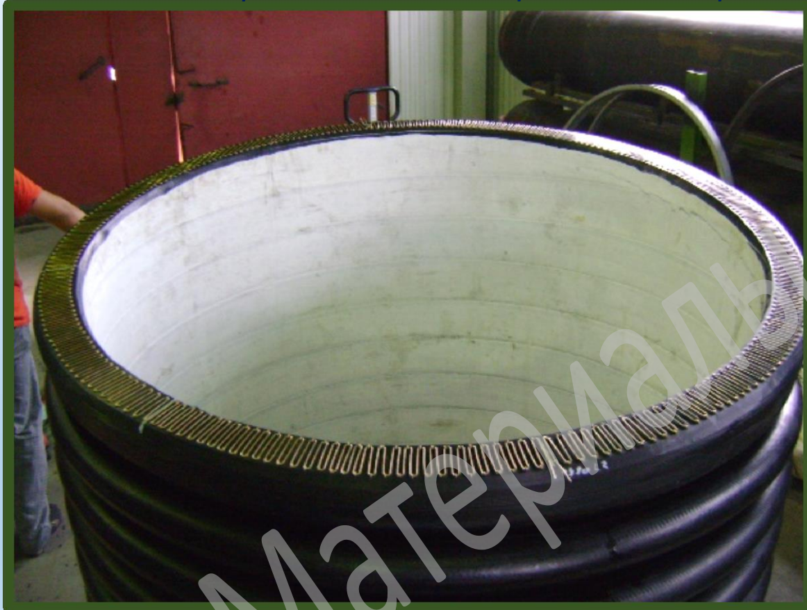
Установка нагревательной спирали для сварки
