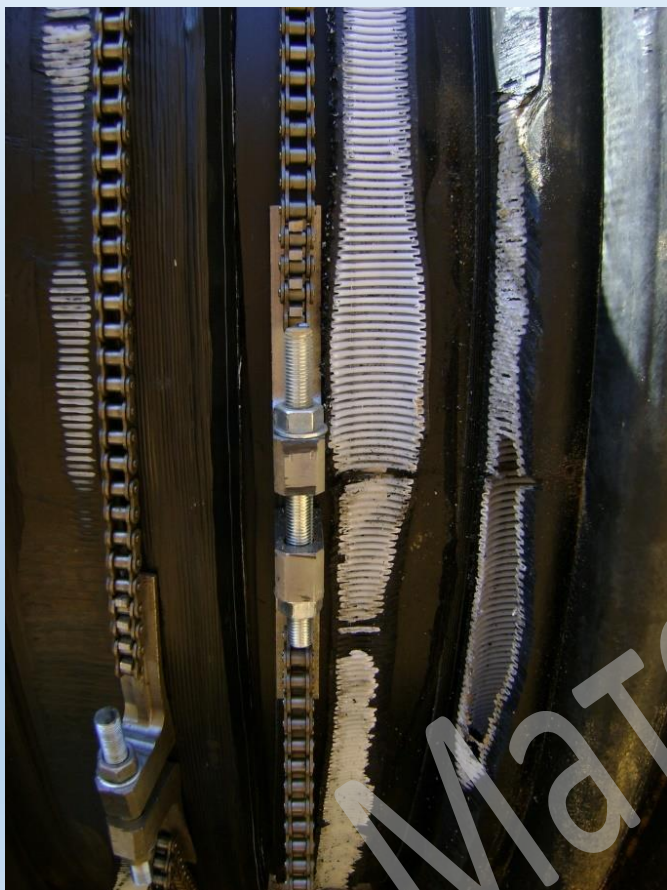
Установка стяжных устройств
