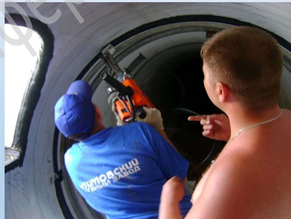
Дополнительная проварка торцевой части электрофузионной муфты
