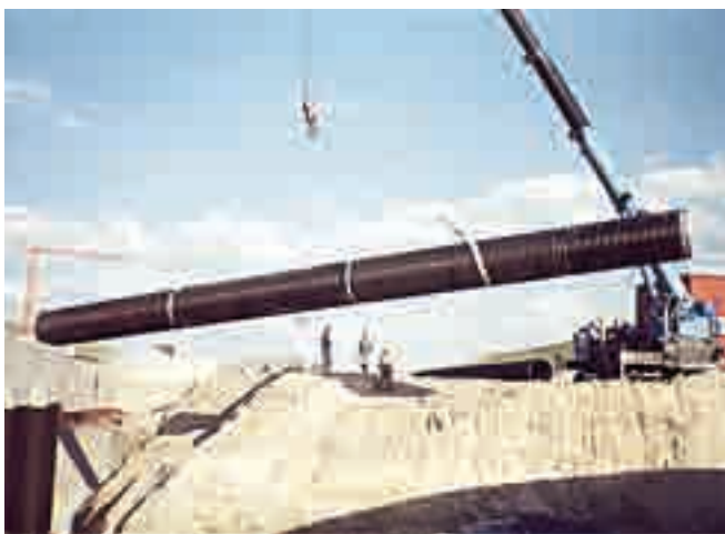
Рис. 2. Укладка в траншею плети труб КОРСИС ПЛЮС
